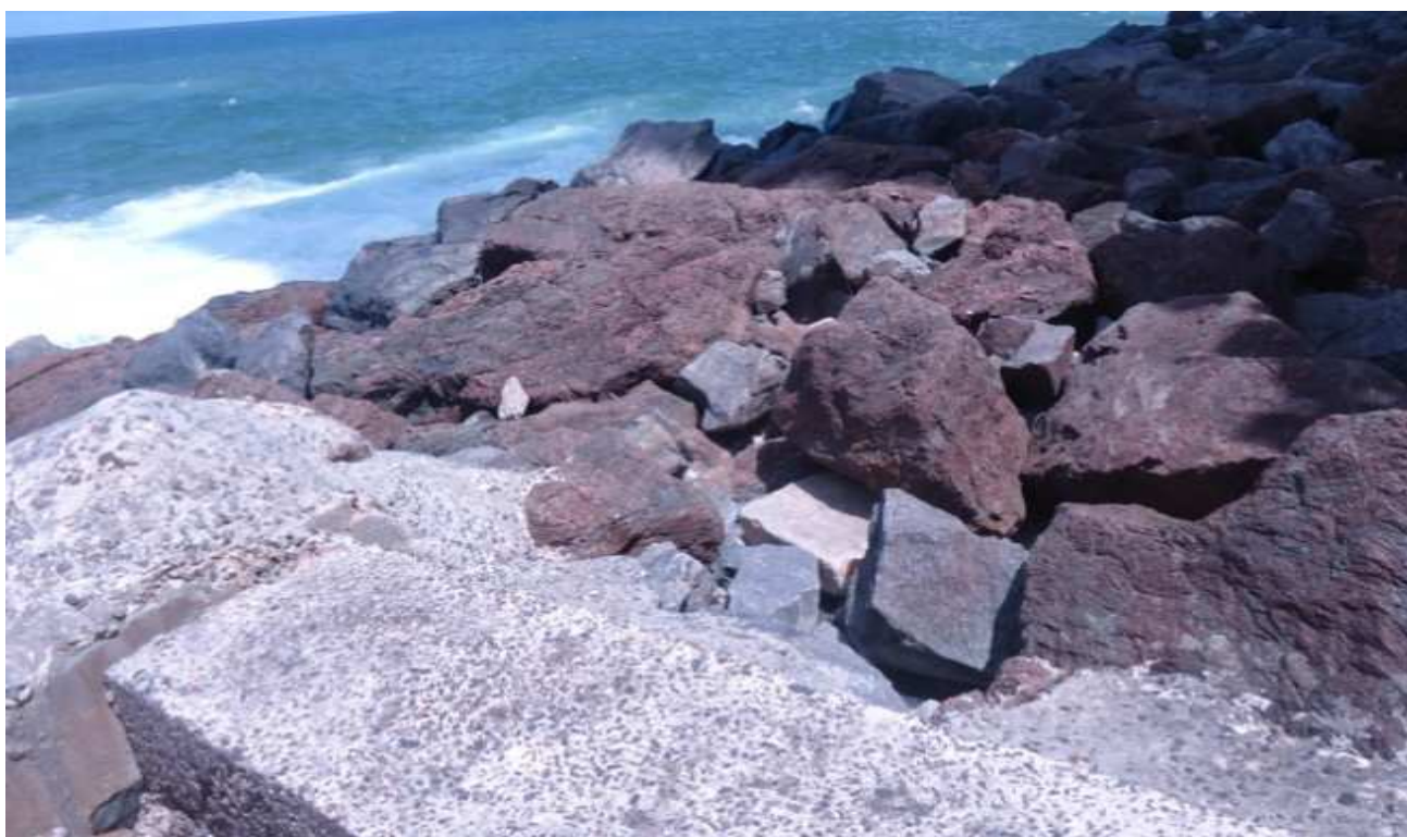
Fotografia 4 - Evidência de lançamento de efluentes ao mar por tubulação, ao fundo do hotel Pestana.
