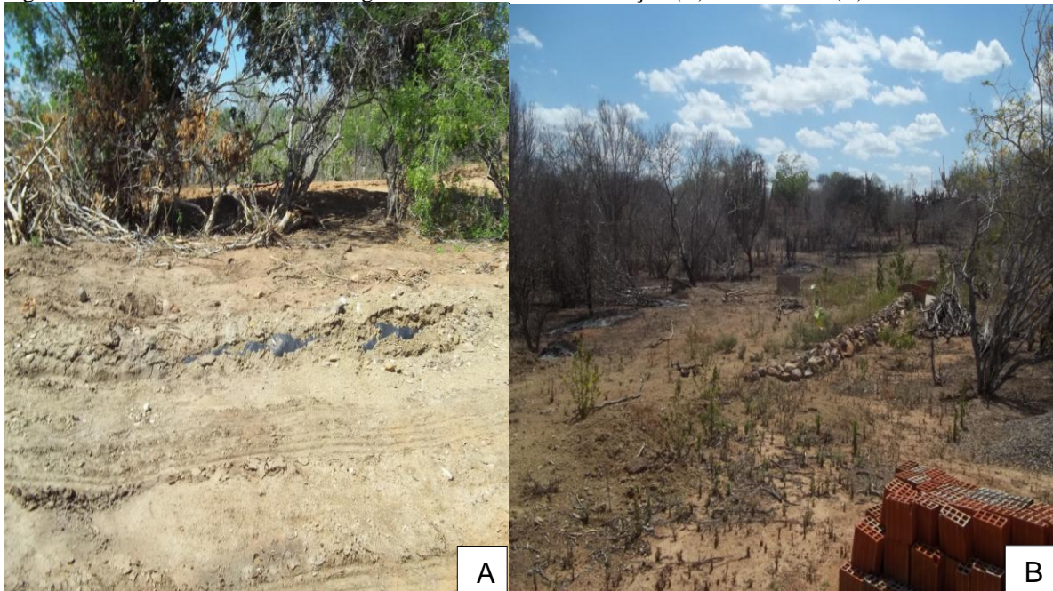
Figura 8 – Espaço Produtivo da Barragem subterrânea: em construção (A) e construída (B)
